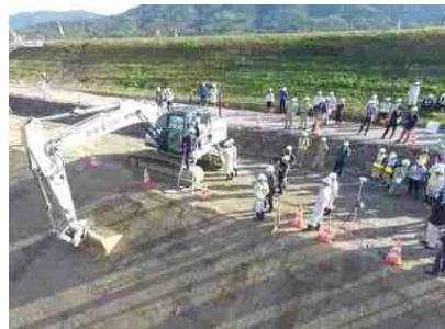
3DMGバックホーによる法面整形
