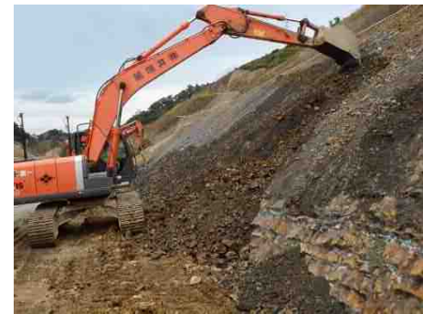
長大法面・流れ盤での掘削
