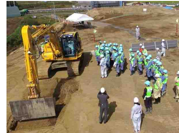
↓ MCバックホウによる盛土法面整形
