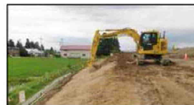
ICTバックホウによる法面整形
