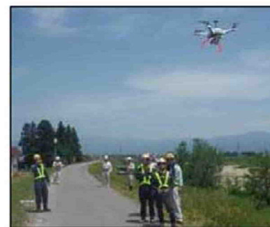
UAV(ドローン)による施工前の測量(5月23日撮影)
