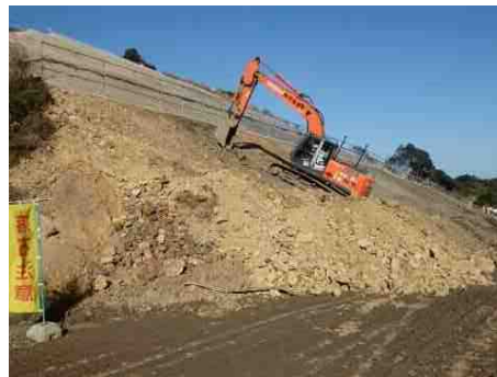
長大法面・流れ盤での掘削
